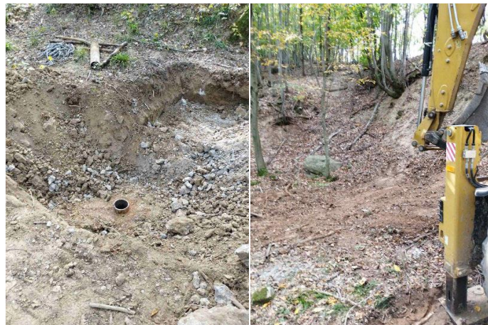
11. ábra: Kútfej visszavágása a terepszint alá, hulladék elszállítása, tereprendezés
