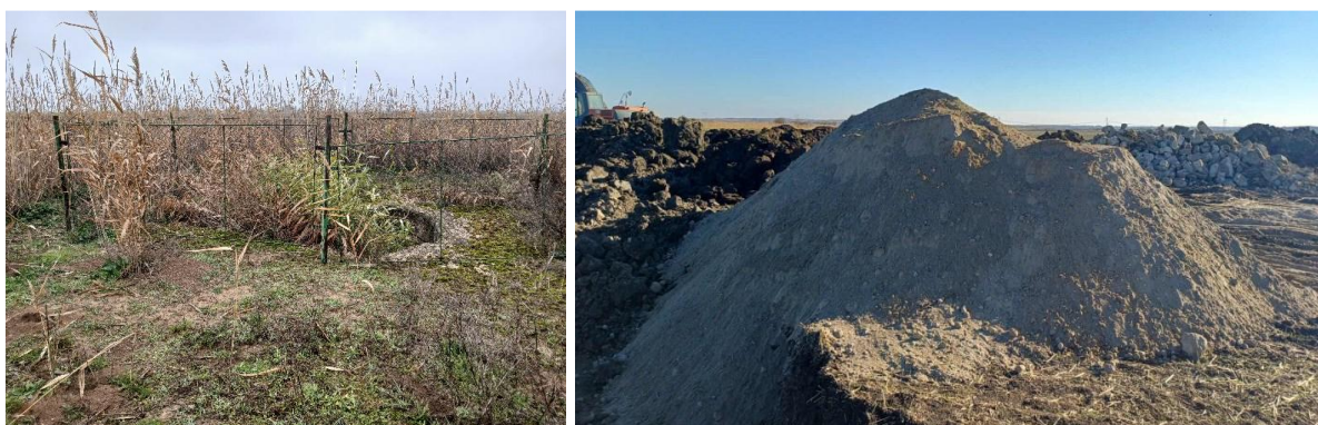
8. ábra: Besenyszögi kút rekultivációs munkái tájrendezés előtt és munkálatok alatt
