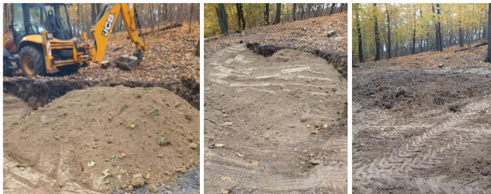
3. ábra: Salgótarjában található tűzivíz-tározó területének feltöltése és helyreállítása
